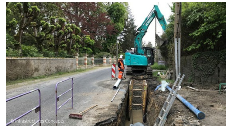
↕ Travaux rue de Langeais à Azay-Le-Rideau (réseau d'eau potable et d'eaux usées)
